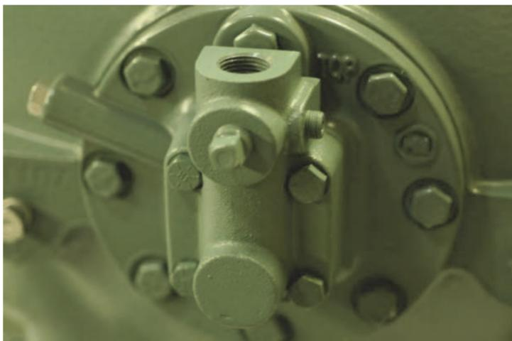
**Fig. 19: Bloque del sensor del interruptor OPSS instalado**
