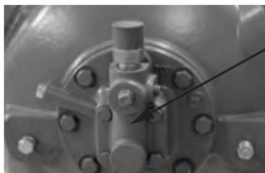
BLOQUE DEL SENSOR DE PRESIÓN DE ACEITE INSTALADO EN FABRICA PARA EL INTERRUPTOR DE SEGURIDAD DE PRESIÓN DE ACEITE (OPSS) QUE ESTÁ DISPONIBLE. PARA OBTENER MÁS INFORMACIÓN, CONSULTE LA SECCIÓN 3.12
