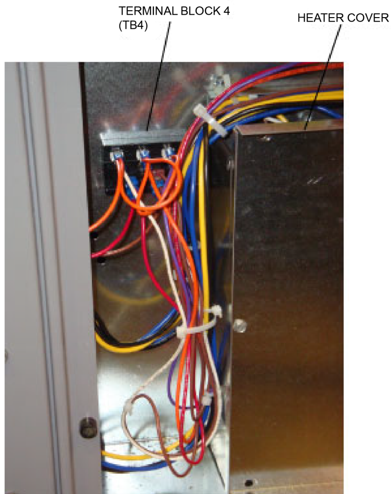
Fig. 51 — Heater Wiring
