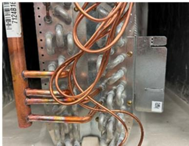
2. Localisez le perforé sur le panneau de la bobine et retirez-le. Installez le passe-fil divisé et faites passer le câble du capteur à travers le panneau.
