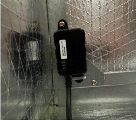
3. Localisez le perforé sur le panneau de la bobine et retirez-le. Installez le passe-fil divisé et faites passer le câble du capteur à travers le panneau.
