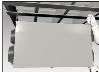
**3** Suspendez le AAF en faisant glisser un maillon de la chaîne dans les crochets de suspension et assurez vous que l'appareil est de niveau.
